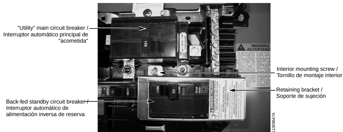
Figure / Figura 1: Installing the Retaining Bracket / Instalación del soporte de sujeción
